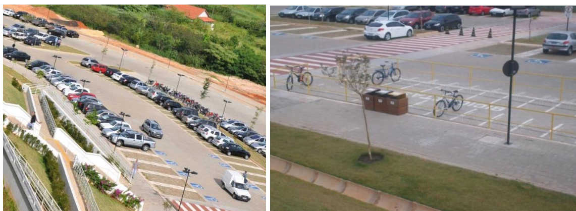
Figura 17- Estacionamento do Paço Municipal de Itu.
