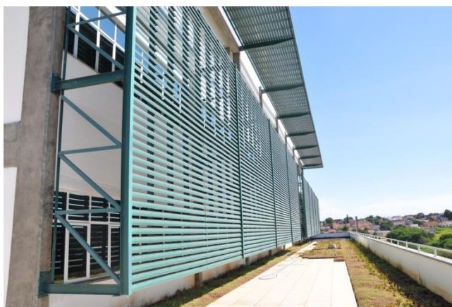
Figura 10 – Instalação de brise no edifício.
