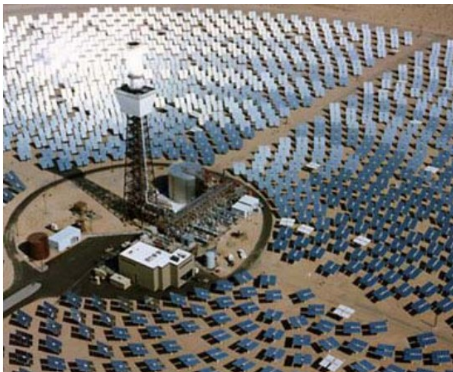
Figura 4.7 – Usina Solar de Barstow- Califórnia:
