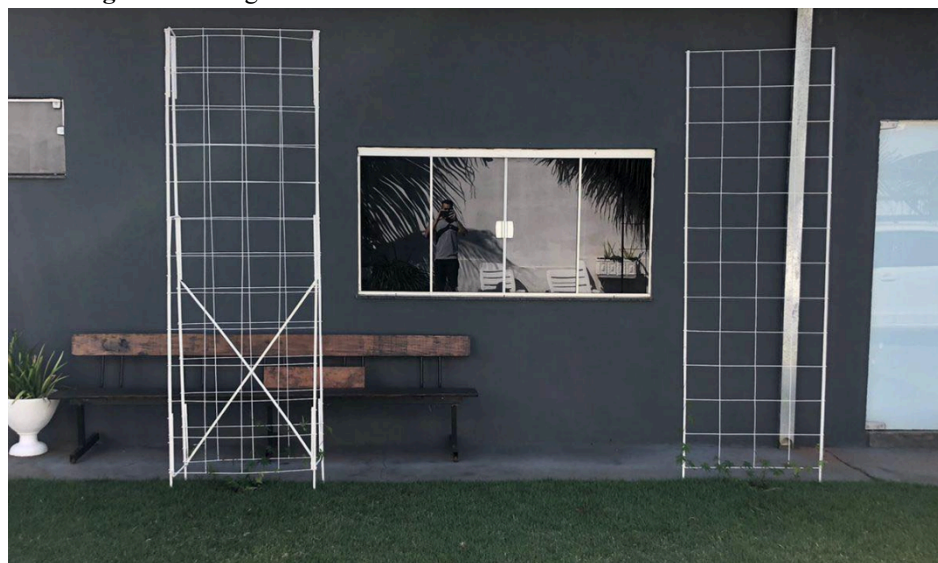
Figura 16: Imagem das fachadas da estrutura das fachadas verdes
