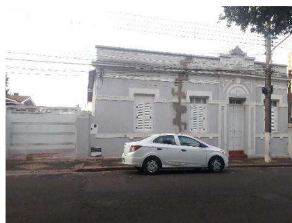
d – Imóvel de Rachel Contrucci Tamassia - Rua Pernambuco nº 1039
