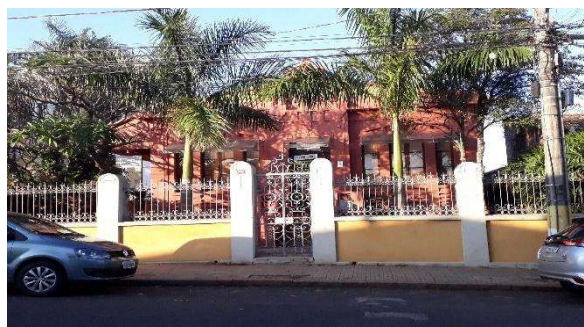
p – 13 - Rua Goiás nº 1656 (residência)
