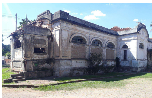
b - Face de quadra da antiga Estação Ferroviária (017aC e 017aD)
