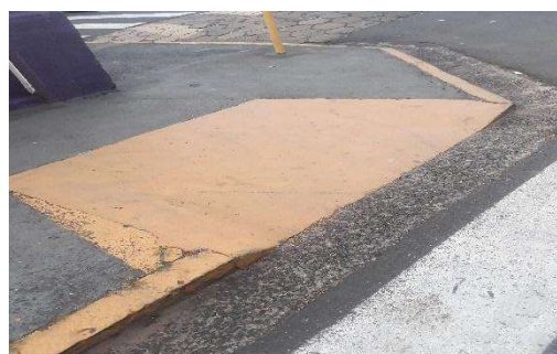
b - Face de quadra Antiga Instalações Sociedade Italiana (512C)
