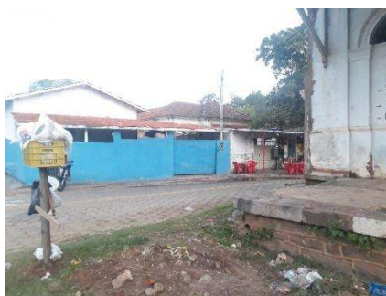
Figura 35 - Exemplo de problema associado ao indicador Condição de manutenção do mobiliário urbano. Face de Quadra da antiga Estação Férrea (017aA)
