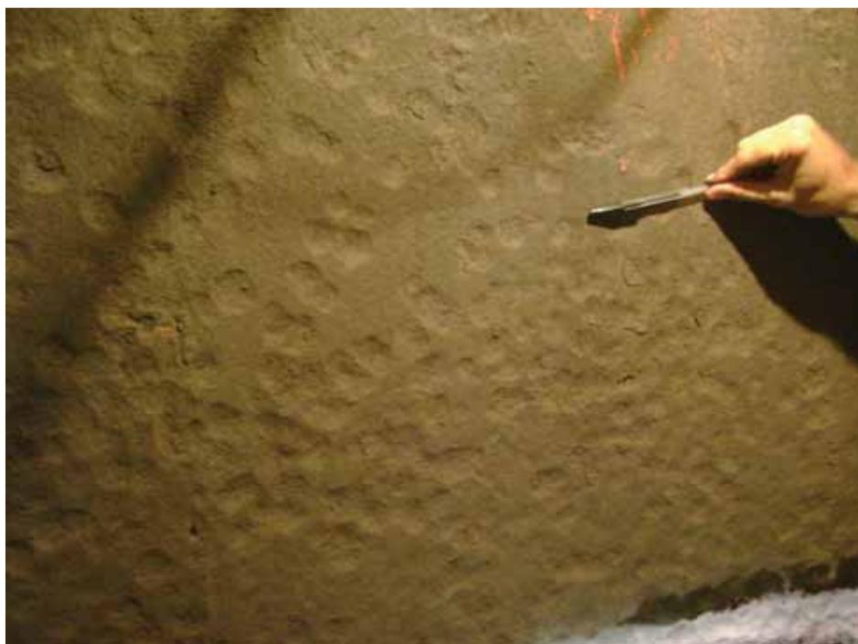
Figura 10 - Chapa interna do corpo com desgaste acentuado
