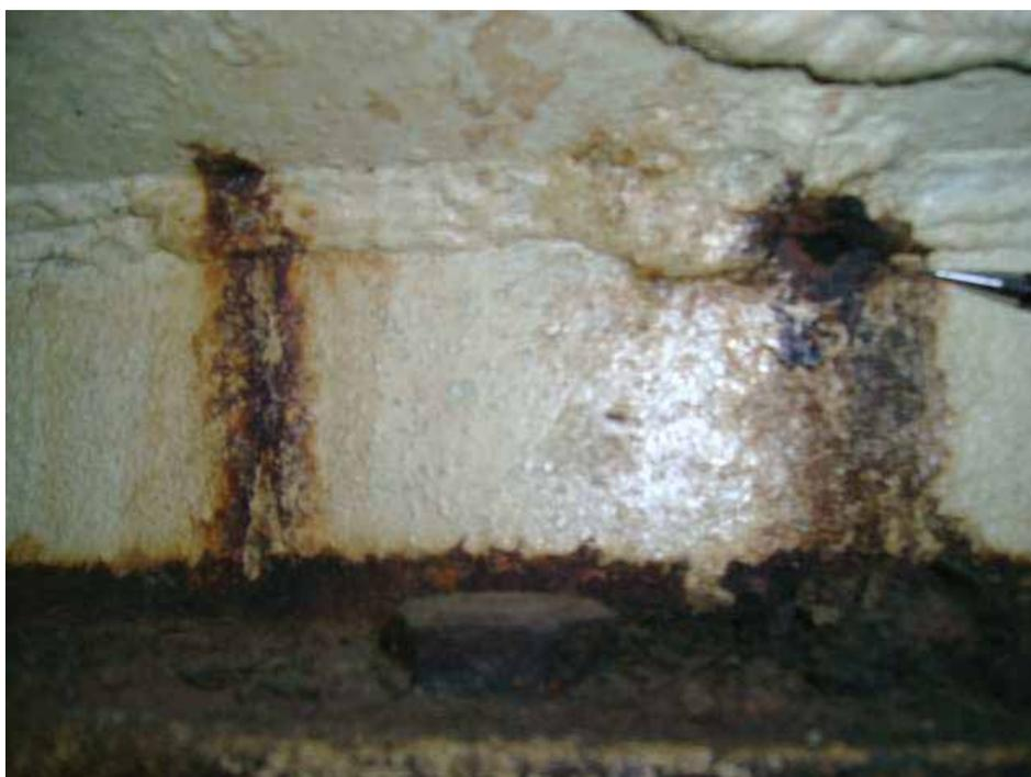
Figura 15 - Fundo do vaso – Detalhe de ruptura em solda
