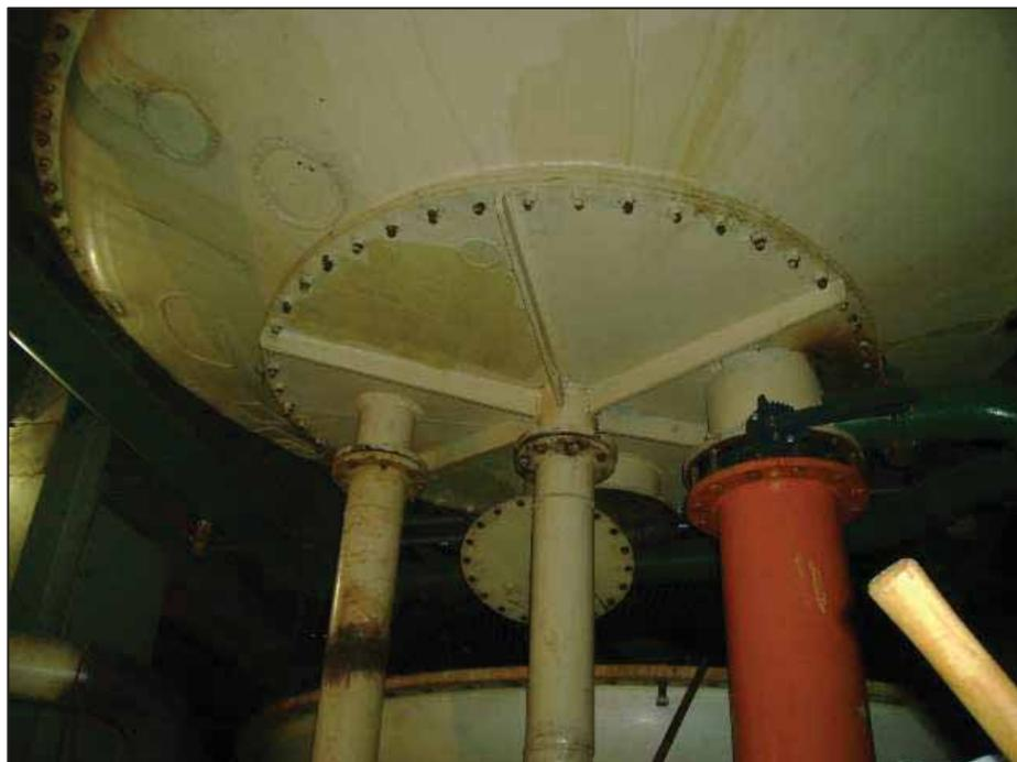
Figura 24 Detalhes de reforços não padronizados
