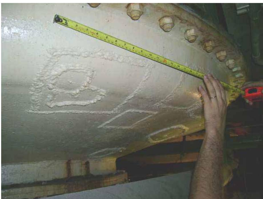
Figura 13 - Fundo do vaso – Detalhe de reparos e reposições
