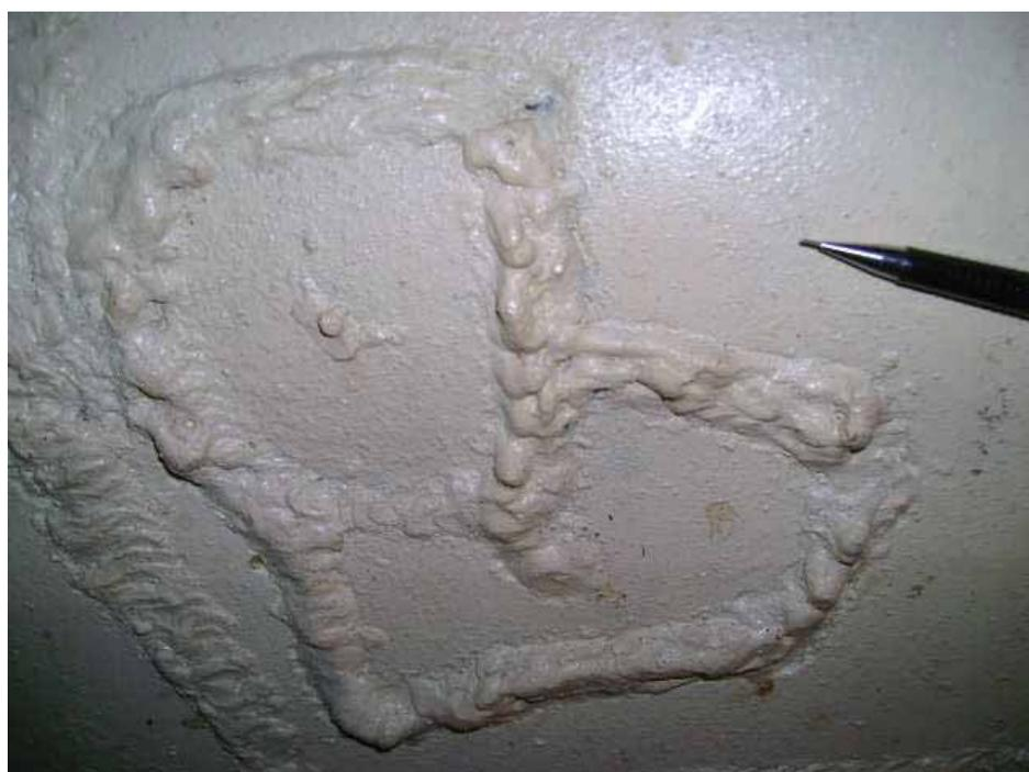
Figura 17 - Fundo do vaso – Detalhe de reparos
