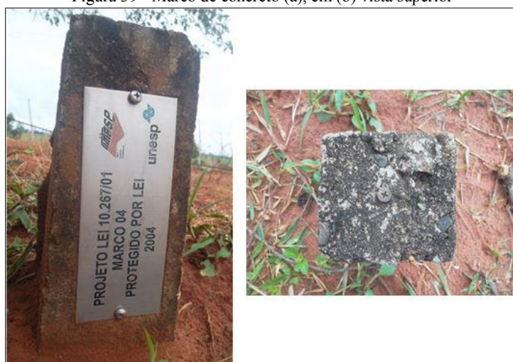
Figura 39 - Marco de concreto (a), em (b) vista superior
