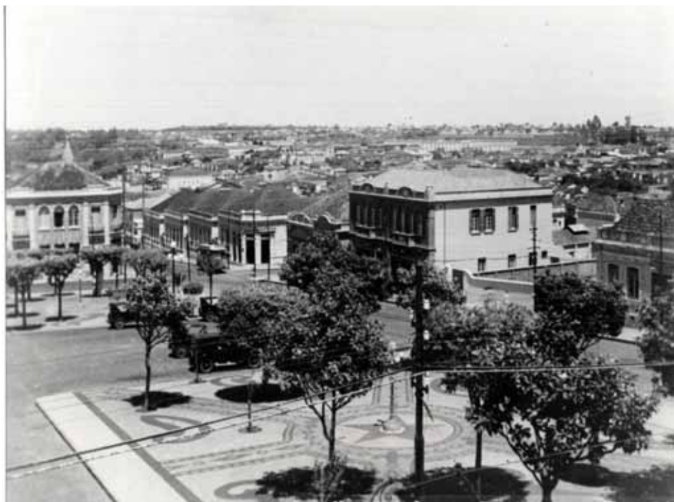
Figura 5. Praça Coronel Salles, 1940. Fonte: Fundação Pró-Memória
