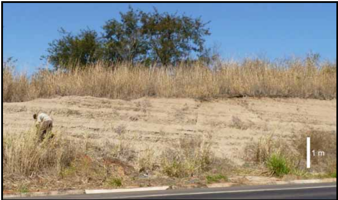
Figura 26. Afloramento da Rodovia Assis Chateaubriand entre os km 346 e 347 ( S21^{\circ}40'42,0''/W50^{\circ}35'40,5'' ), município de Iacri.
