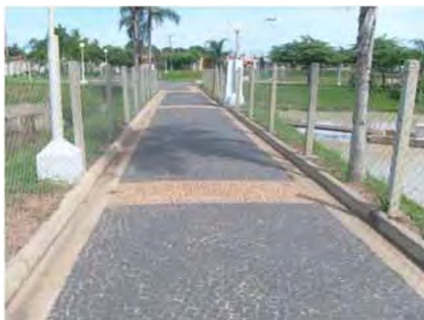
Corredor entre os dois reservatórios
