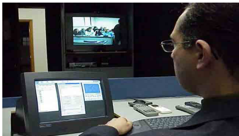
Figura 6- Sala de geração
