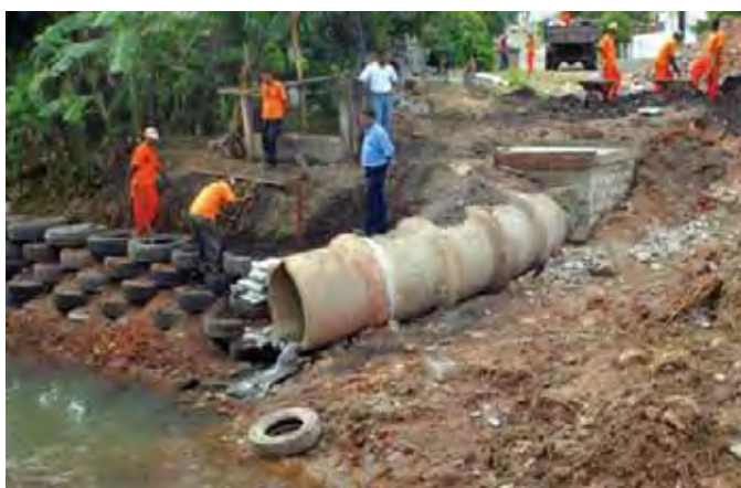
Figura 12 – Exemplo de uma obra drenagem com pneus inservíveis.
