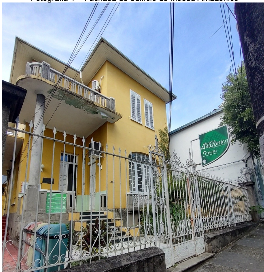
Fotografia 1 – Fachada do edifício do Museu Amazônico
