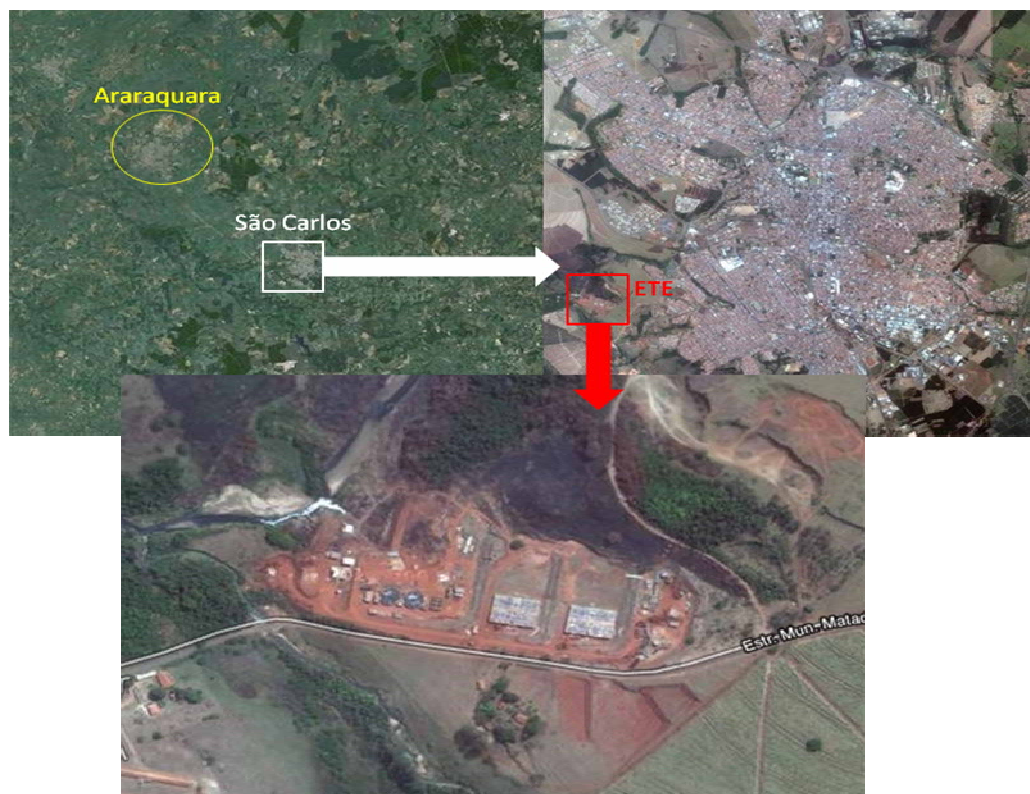
Figura 2 – Localização da ETE Monjolinho em São Carlos-SP. Em destaque, vista aérea ampliada da ETE.
