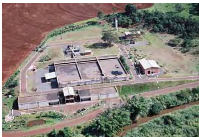
Figura 5 - Foto aérea da ETE de Jaú-SP.
