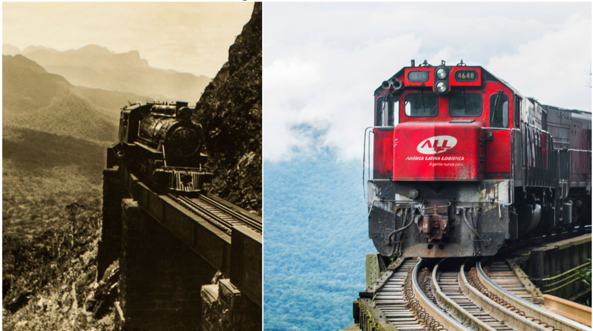
Figura 16 — Colagem com uma fotografia histórica e uma recente da passagem de um trem na Ferrovia Curitiba - Paranaguá, no Viaduto do Carvalho, na Serra do Mar.
