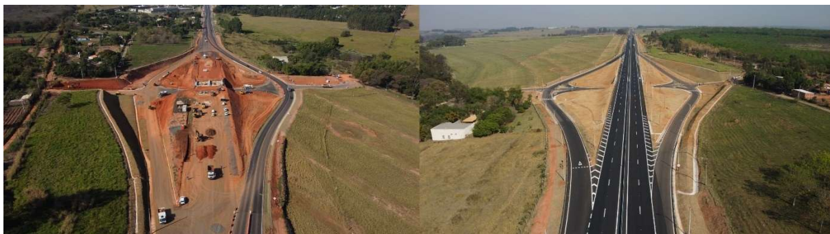
Figura 22 – Durante e pós obra.
