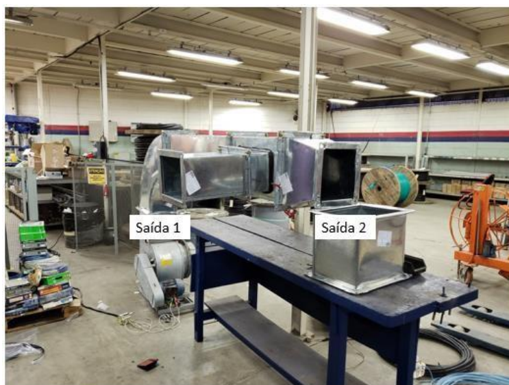
Figura 13 – Identificação das saídas do duto.
