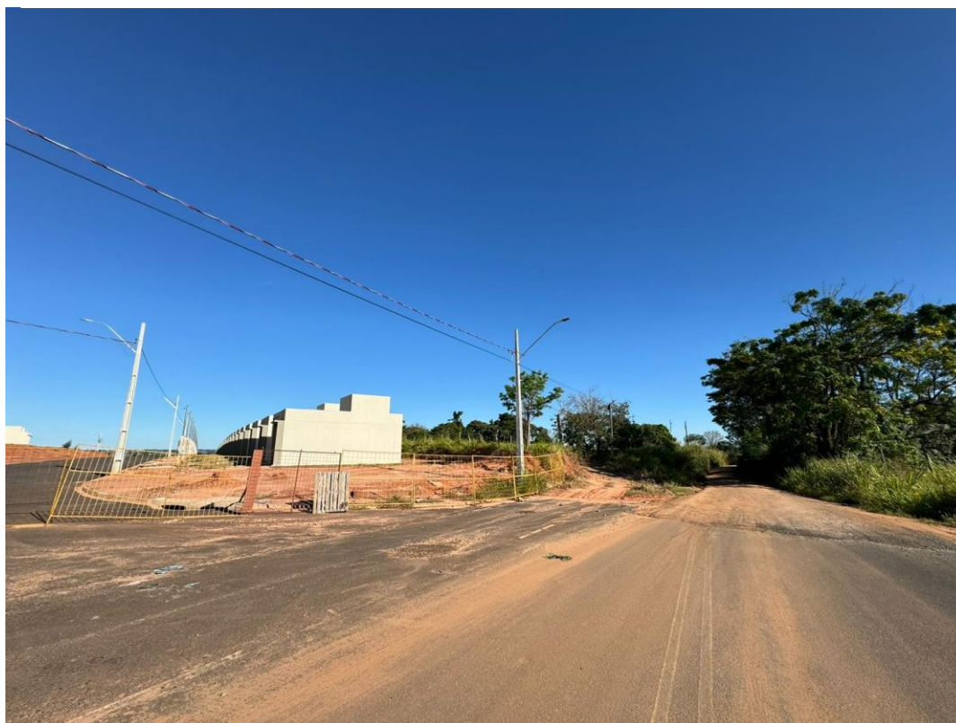
Figura 22. Residencial Minerva: estrada de acesso (2024)
