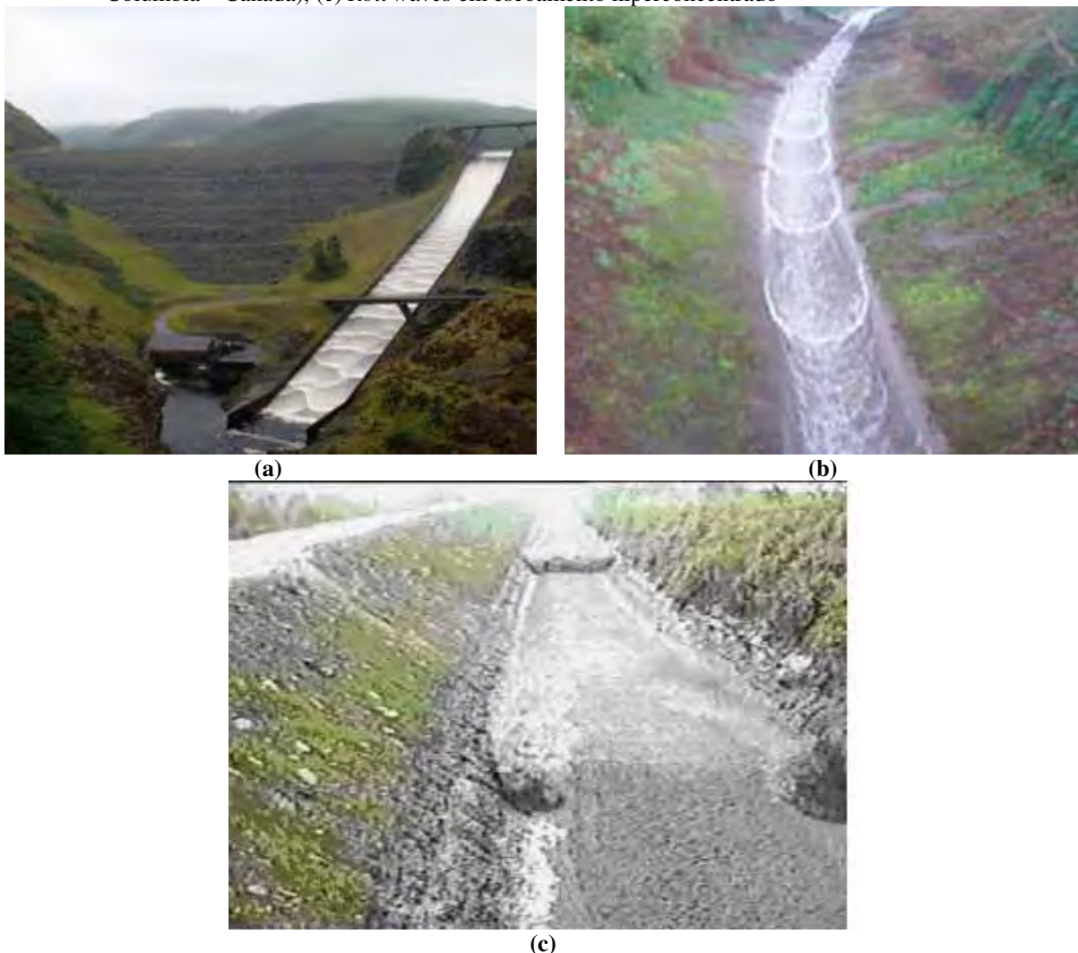
Figura 3 - Propagação de roll waves em canais artificiais: (a) Roll waves em vertedouro do reservatório de LlynBrianne, em Wales, Reino Unido, (b) Roll waves em um canal de concreto, (Lions Bay, British Columbia – Canadá), (c) Roll waves em escoamento hiperconcentrado
