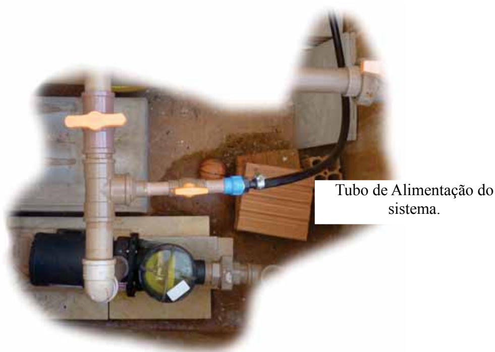
Figura 7: Esquema de ligação da bomba da piscina para alimentação do sistema.
