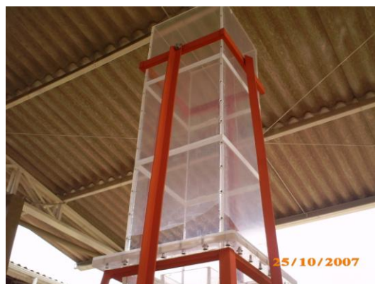
Figura 4.11 – Câmara de flotação acoplada acima das pirâmides de floculação, fase de construção.
