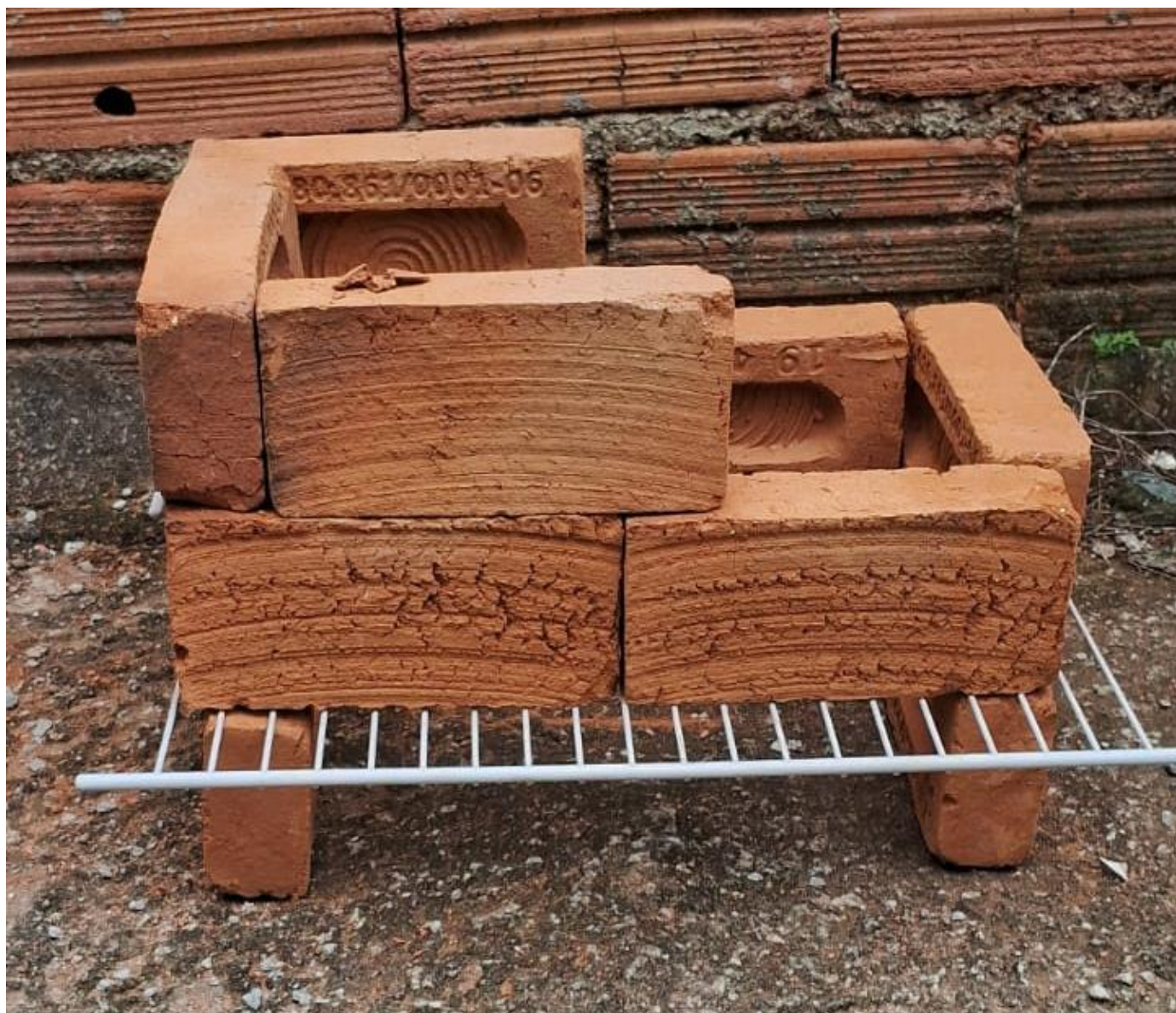
Figura 29 – Montagem da estrutura do forno
