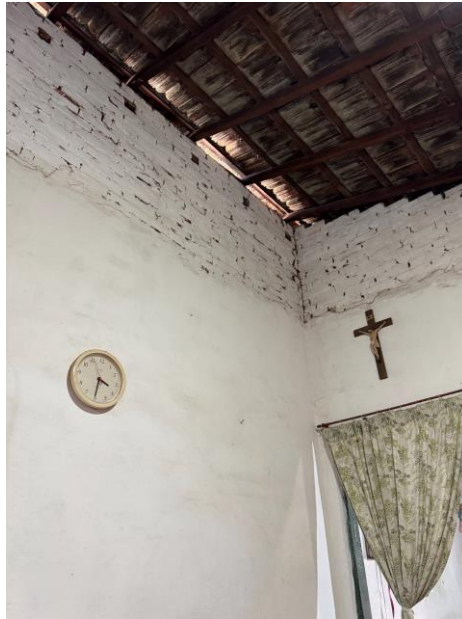
Figura 11: Casa com teto sem forro da Dona Orides
