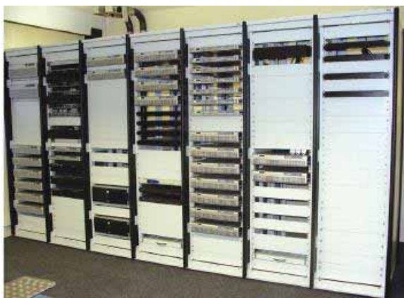
Figura 19 – Central Técnica I
