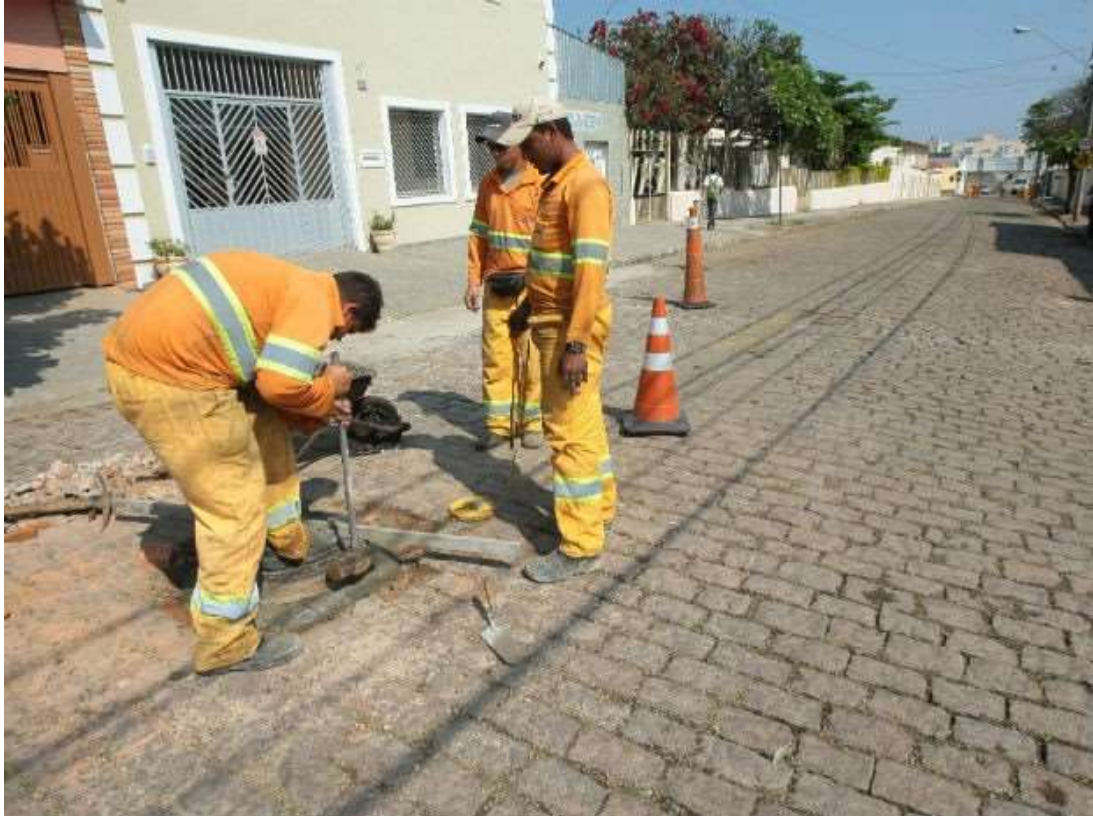
Figura 5 – Reparo de pavimentação com paralelepípedos em Sorocaba, SP.
