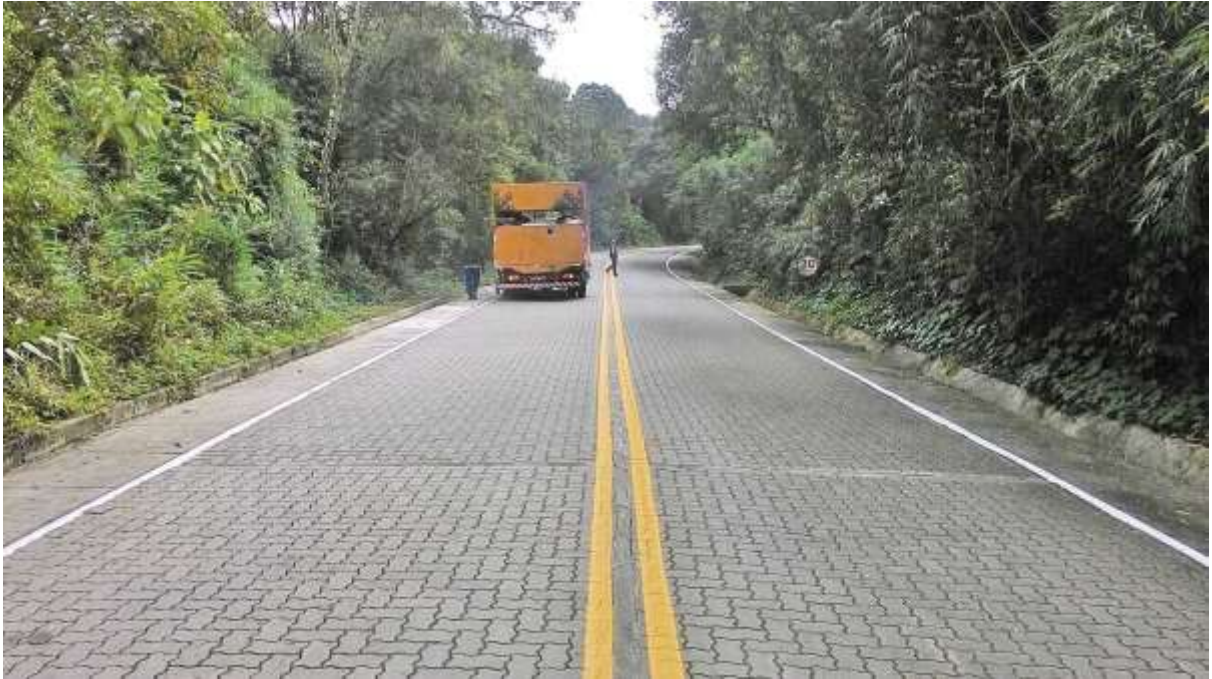
Figura 8 – Trecho da rodovia RJ-165 pavimentado com pavers.
