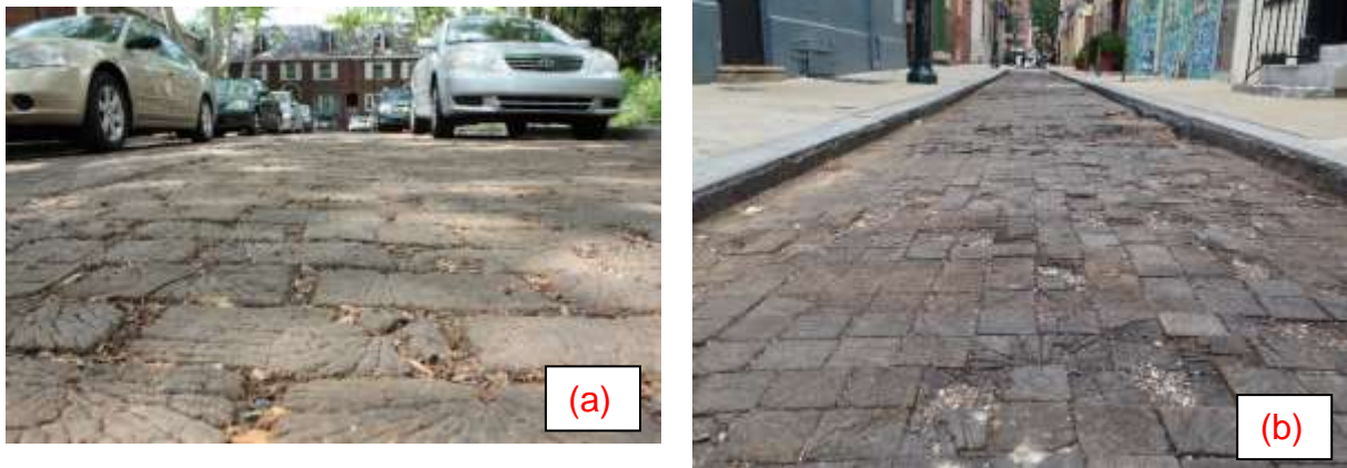
Figura 7 – (a) Pavimento de blocos de madeira em Roslyn Place, Pittsburgh; (b) Pavimento de blocos de madeira em South Camac Street, Philadelphia.
