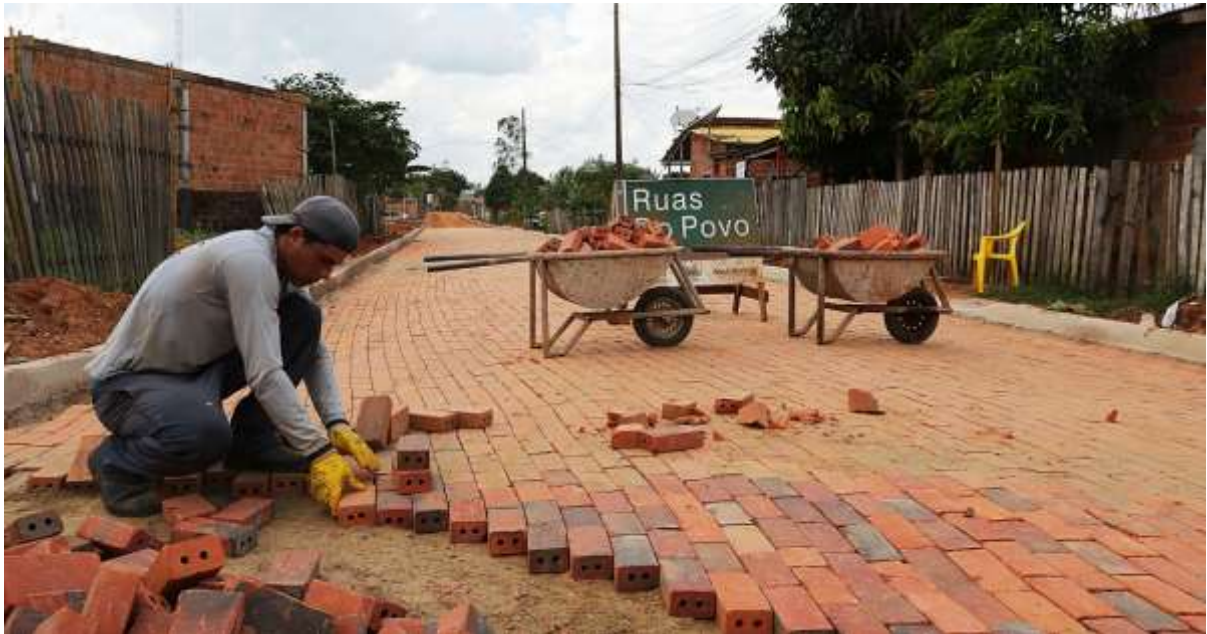
Figura 4 – Aplicação de pavimento em Rio Branco, AC.
