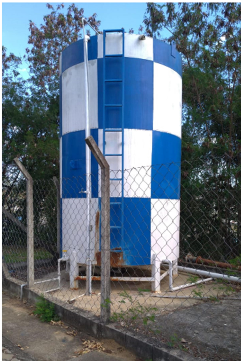
Figura 11 – Reservatório Geral de 30.000 litros
