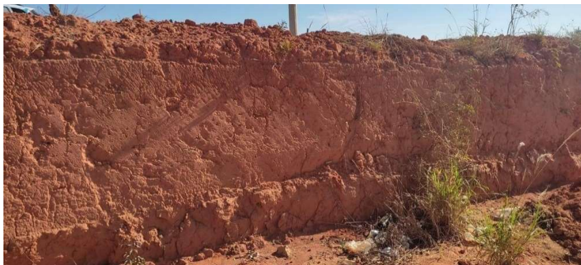
Figura 5.3. Ilustração de exposição de perfil de solo com feições indicativas de erosão laminar e escorregamento superficial. Fonte: autora. Data: 21 jul. 2022.
