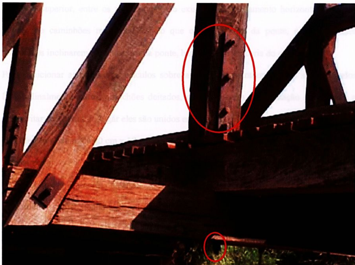
FIGURA 31 – Ligação do pendural à transversina através da chapa-parafuso
