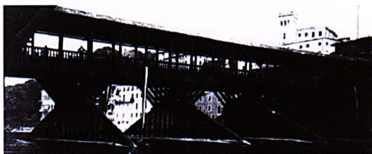
FIGURA 4 - Ponte dos Alpes em Bessano. FONTE: BENNETT (1999)
