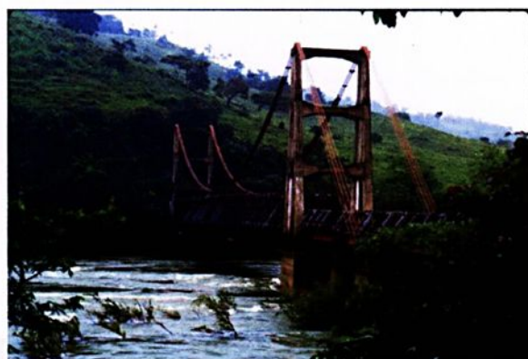
FIGURA 13 - Vista geral da ponte pênsil de Xavantes. FONTE: VASCONCELOS (1993)
