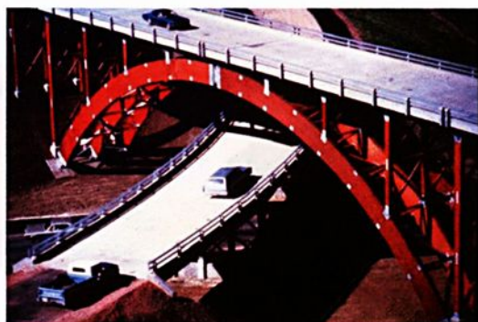
FIGURA 8 - Ponte em MLC nos EUA. FONTE: FPL (1999)
