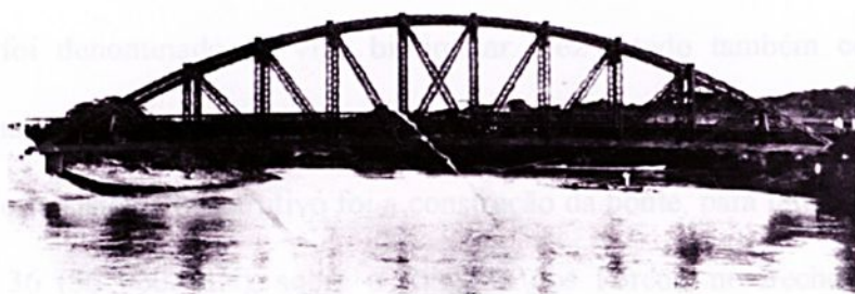
FIGURA 15 - Ponte em arco em Guarulhos. FONTE: CESAR E CALIL (1992)
