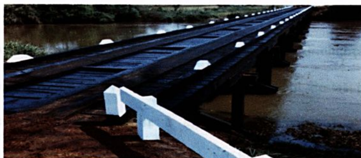
FIGURA 23 - Ponte tipo viga simples
