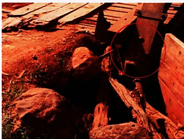
FIGURA 53 – Entalhe em contacto com o solo
