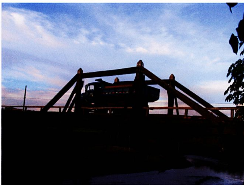
FIGURA 37 - Vista do caminhão e réguas na ponte
