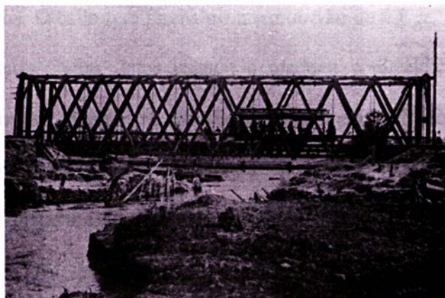
FIGURA 11 - Ponte sobre o rio Tamanduateí em São Paulo. FONTE: VASCONCELOS (1993)
