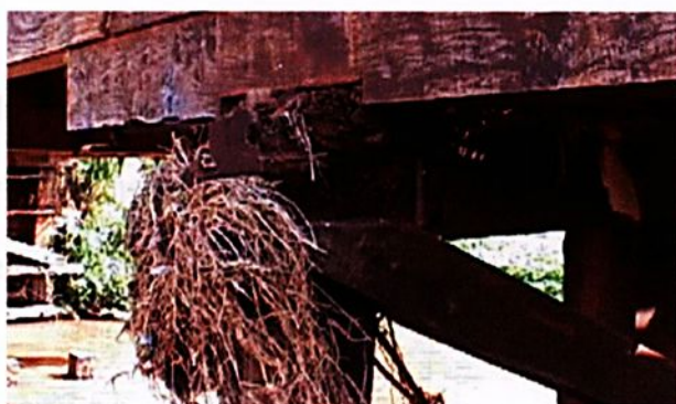
FIGURA 24 – Vegetação no pilar
