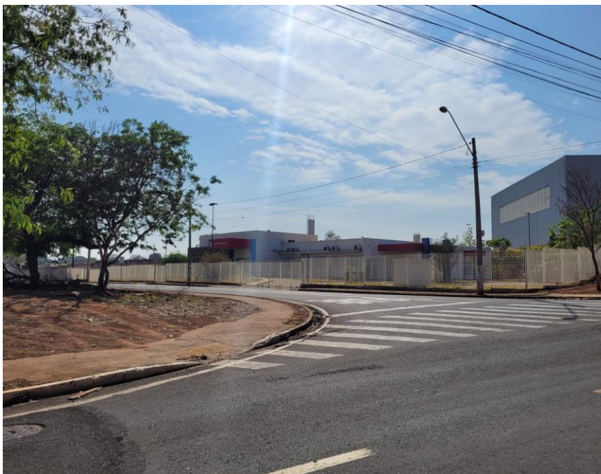
Figura 27 - UBS Residencial Lealdade e Amizade, zona leste do município de São José do Rio Preto-SP.
