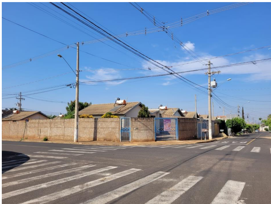
Figura 26 - Exemplo de construções no bairro Lealdade e Amizade, zona leste do município de São José do Rio Preto-SP.
