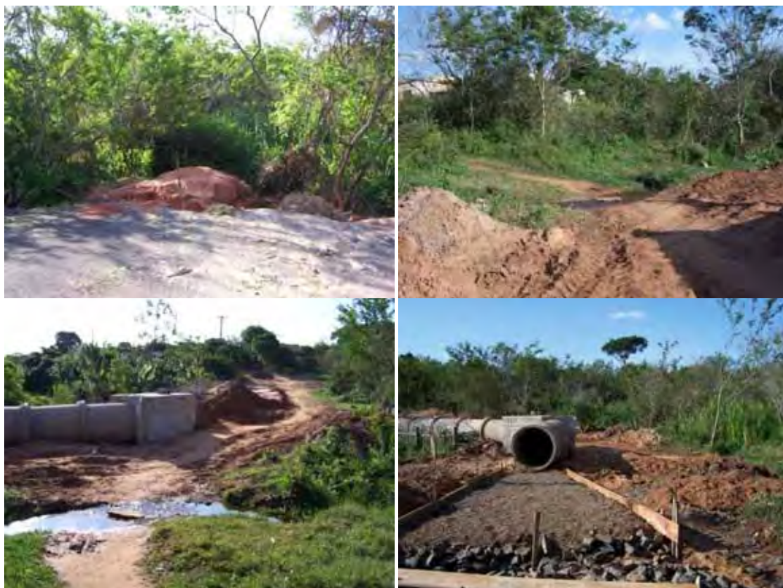
Figura 33: Início das obras de construção da rua que atravessará sobre o brejo na localidade 1.
