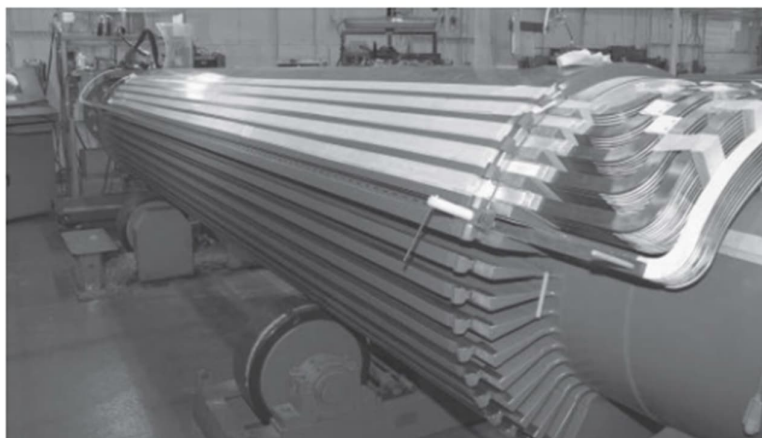
Figura 20 - Instalação do enrolamento de campo no rotor de um gerador síncrono de 2 polos.
