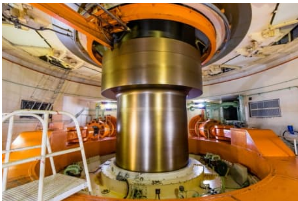
Figura 16 - Eixo que acopla a turbina ao gerador.
