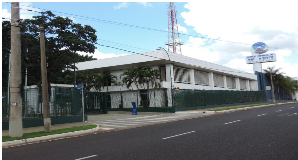
Figura 12 – Foto da Fachada TV TEM São José do Rio Preto
