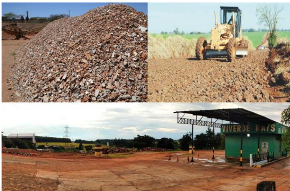
Figura 34: Área de triagem e britador da usina Viverde Rays.
