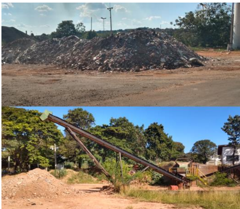
Figura 37: Detalhes das instalações e materiais empilhados na Usina Municipal de reciclagem de RCD.
