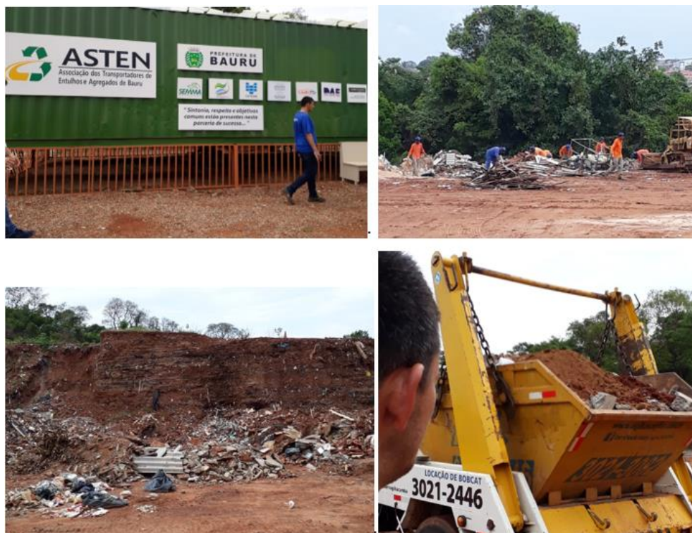
Figura 36: instalações e operações de recebimento e triagem pela ASTEN.
