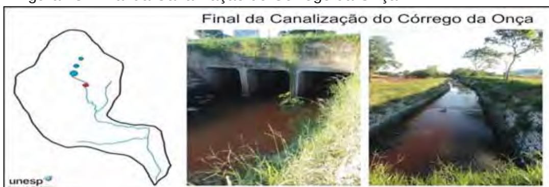
Figura 43: Final da Canalização do Córrego da Onça.
