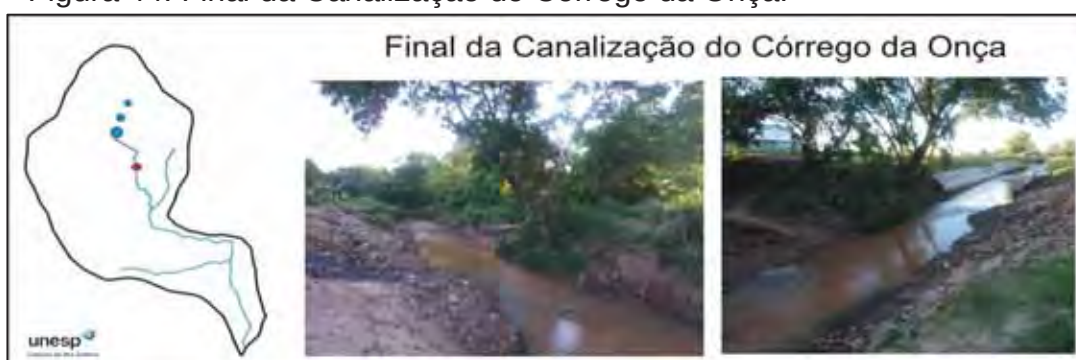
Figura 44: Final da Canalização do Córrego da Onça.
