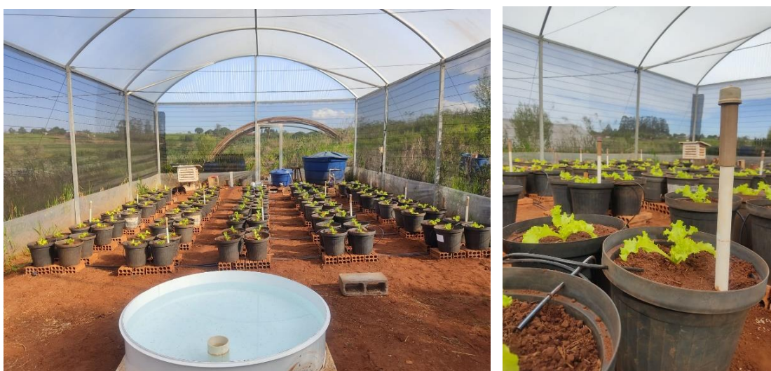
Figura 25 - Tensiômetros instalados na área para o manejo da irrigação
