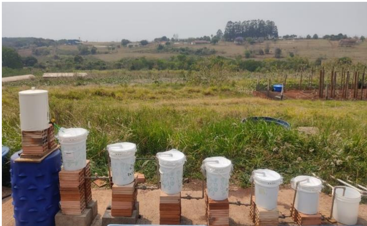
Figura 17 - Imagem do sistema de filtragem instalado e em funcionamento
