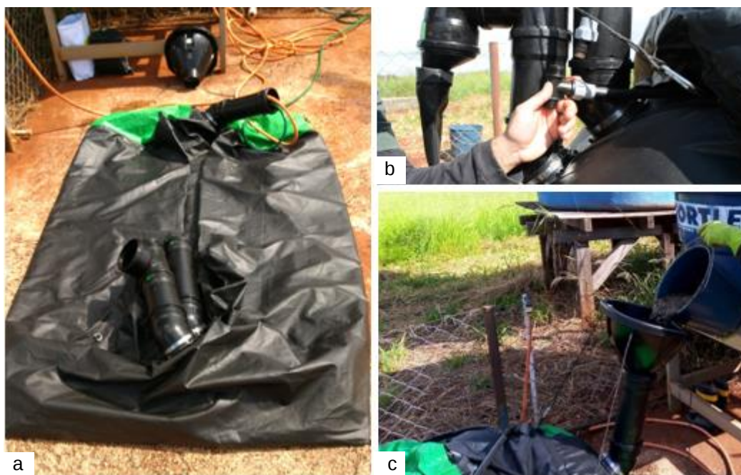
Figura 10 - Instalação e ativação do biodigestor HomeBiogas™ na FCA/UNESP 1
