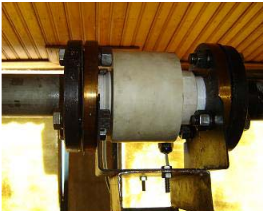
Figura 3.11 – Local de instalação do medidor de vazão, MV, na tubulação de recalque.
