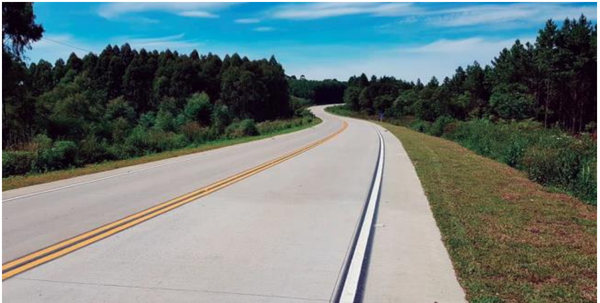
Figura 3.8 Pavimento rígido (FRASSON JR et al., 2020).
