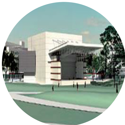
Figura 49. Imagem eletrônica da entrada principal do teatro, ultimo elemento que compoe a praça de convivência; Fonte: < http://www.arcoweb.com.br/projetodesign/arquitetura/aflalo-amp-gasperini-arquitetos-parque-sao-31-10-2008 >
