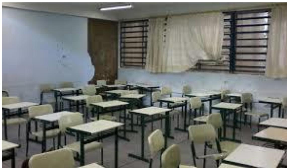
**FOTO 5 – Sala de aula com infiltração**
