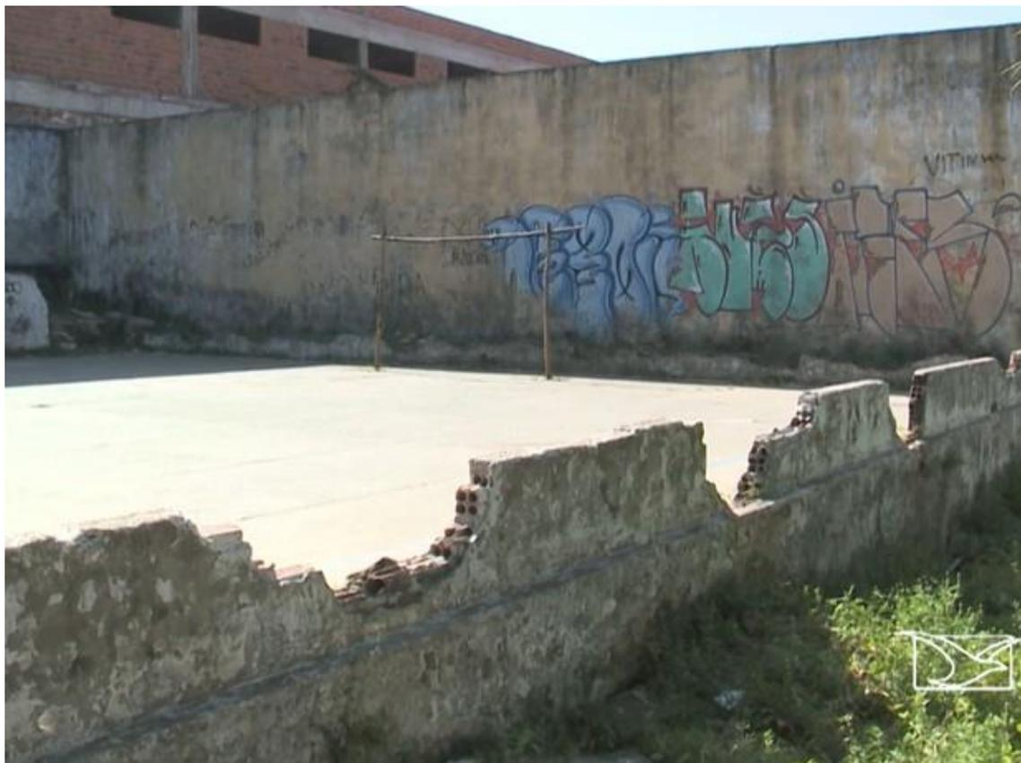
**FOTO 11 – Muro de proteção da quadra danificado**
