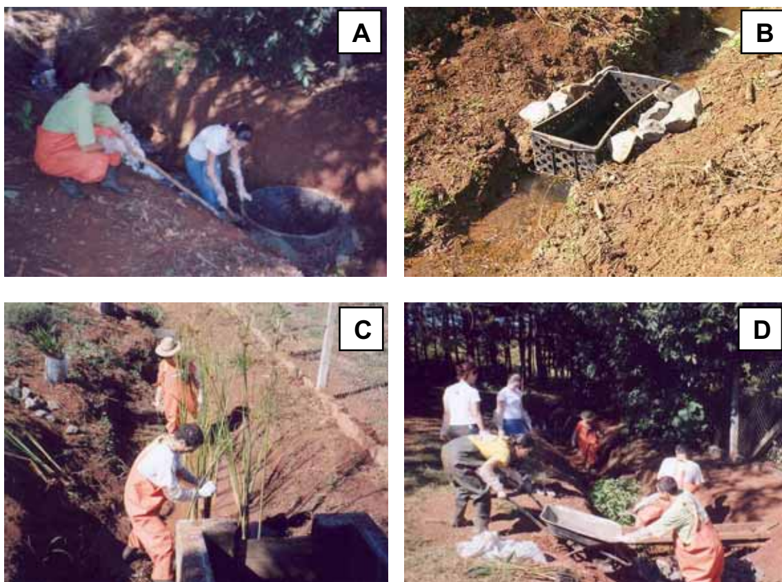
Figura 6. Fixação das caixas plásticas dentro do “wetland” (A e B), Cyperus giganteus e Typha domingensis sendo plantadas no “wetland” (C) e Pontederia cordata e Eichhornia azurea sendo plantadas no “wetland” (D).
