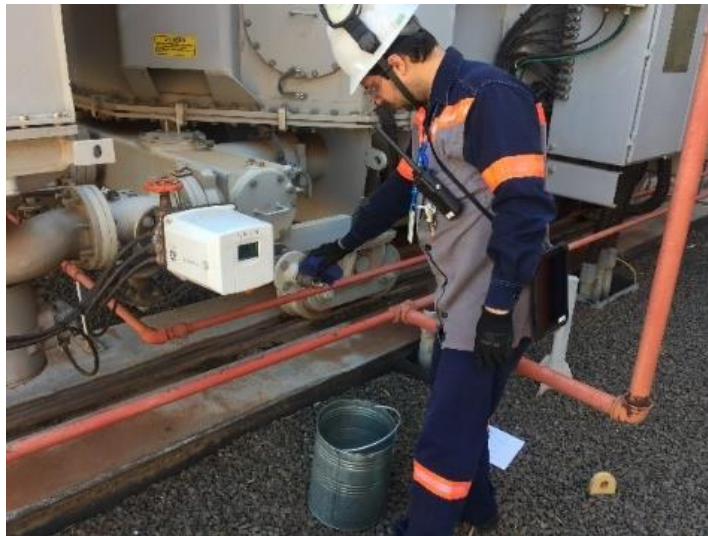
Figura 3 - Retirada do tampão da válvula e limpeza do ponto de acesso.
