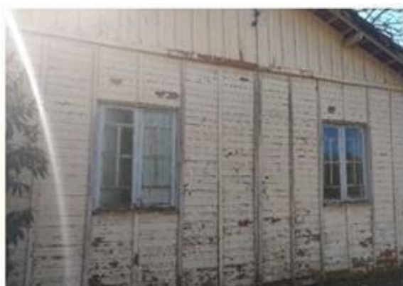
FIGURA 41: Edificação de madeira implantada pela EFS
