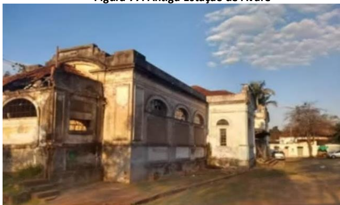
Figura 77: Antiga Estação de Avaré
