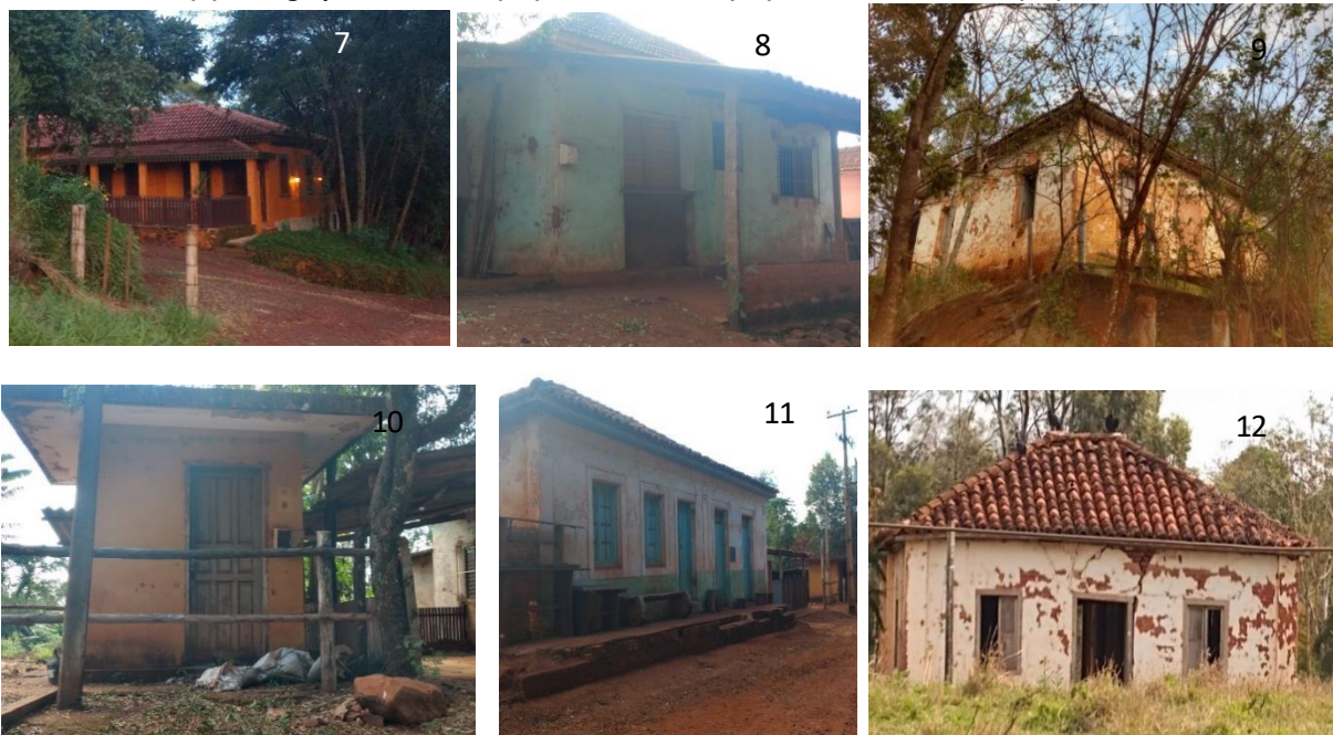
FIGURA 84: Da esq para a dir. Residência em Restauro (7); Merceria 01 (8); Escola do bairro Andrade e Silva (9); Abrigo para telefone (10); Merceria 02 (11); Casa Abandonada (12);
