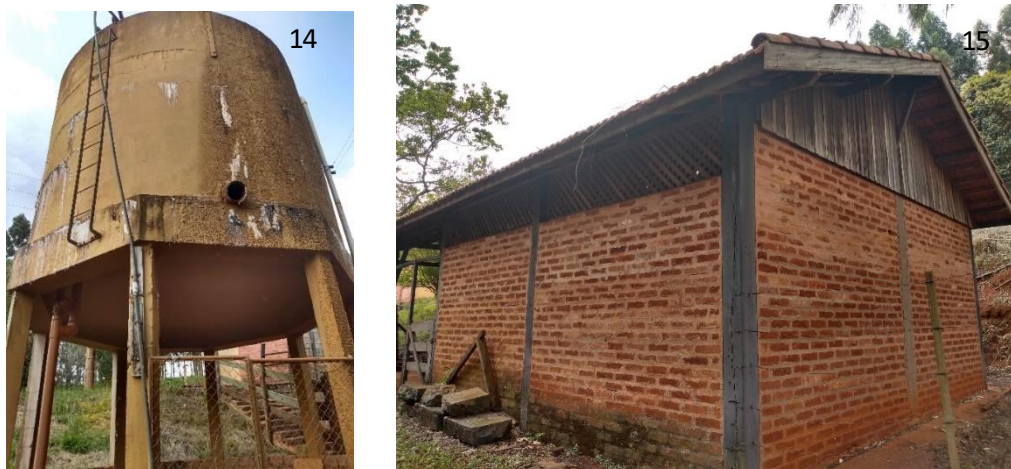
FIGURA 86: Da esq para a dir. Caixa D'água em concreto (14); Antiga Oficina (15);
