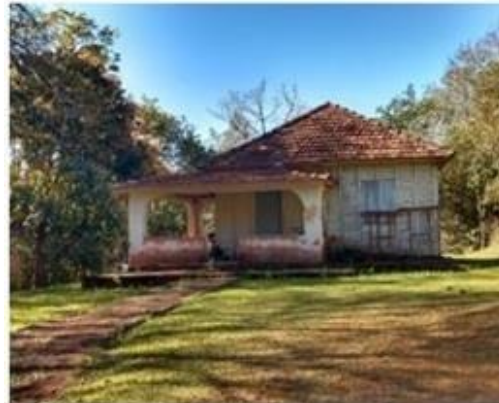
FIGURA 42: Edificação em alvenaria do período da EFS
