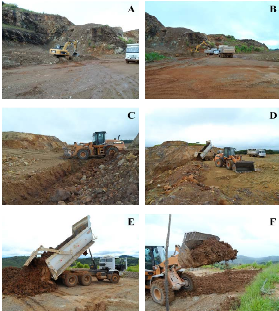
Figura 22 - Em A e B carregamento do banco de sementes do solo, em C e D reabertura das vias de acesso, e em E e F, procedimento de recomposição do banco de sementes do solo sendo executado. (Fotos do autor).
