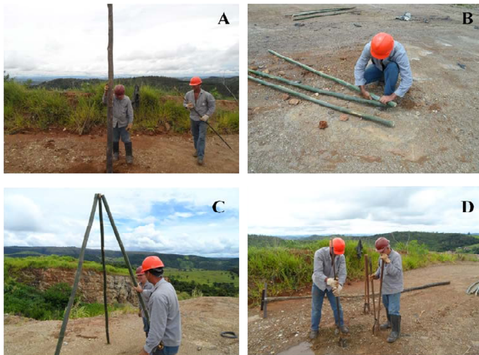
Figura 26 - Em A e B instalação dos poleiros de 5 m. de eucalipto, e em C e D instalação dos poleiros de 3 m de bambu. (Fotos do autor).
