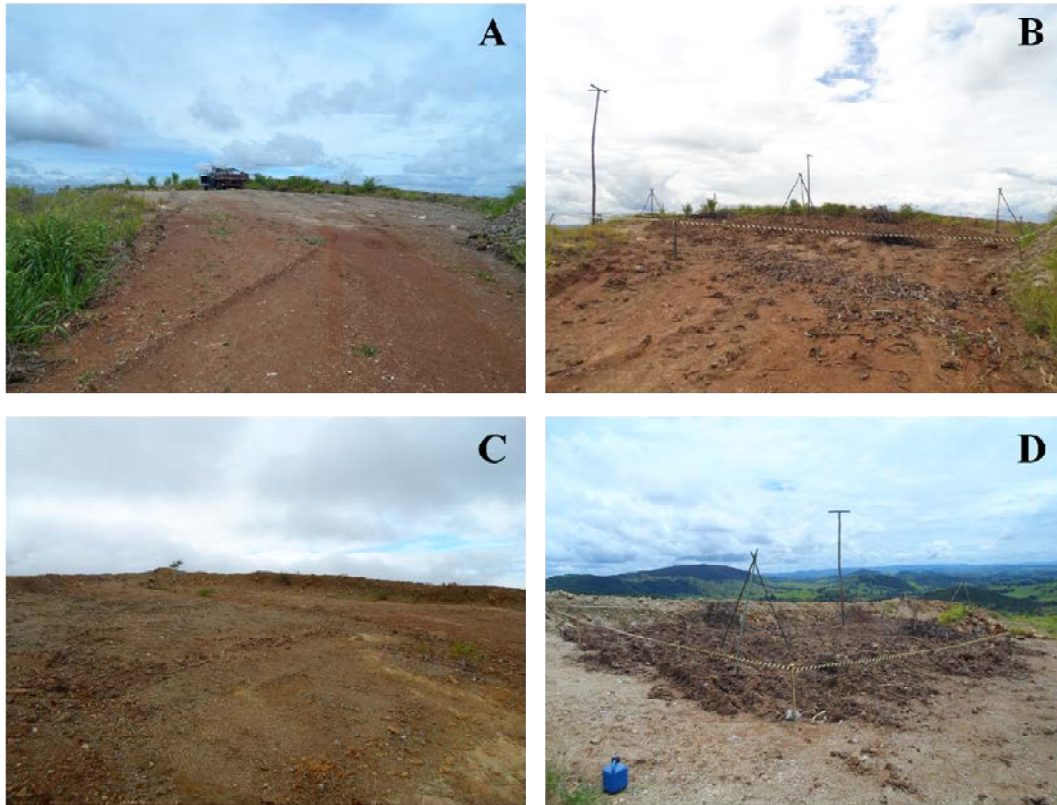
Figura 37 - Em A e B área de experimento 1, antes e depois da recomposição do solo, e em C e D a área 2 após o mesmo procedimento. (Fotos do autor).
