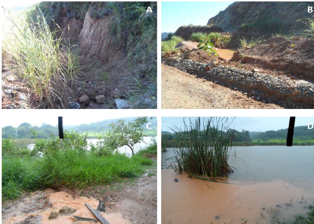
Figura 13 - Em A e B, Processo de erosão laminar e assoreamento do córrego água limpa, barramento 3, período chuvoso. Em C e D Bacias de contenção no entorno da mina. (Fotos do autor).
