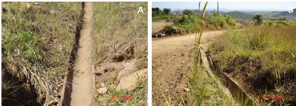
Figura 10 - Canaletas de drenagem da mina direcionando o fluxo de água e sedimentos para os barramentos 1 e 2. (Fotos do autor).
