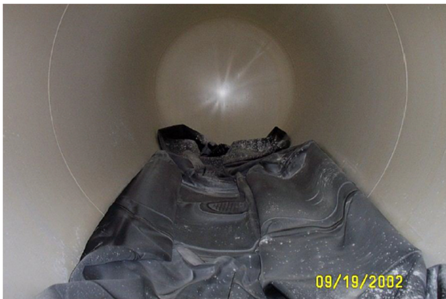
Figura 23. Detalhe: bexiga não inflada no interior do RHO. Fonte: Saint-Gobain.
