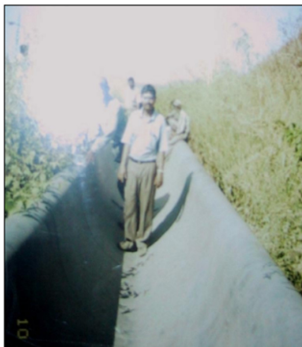
Figura 6. Resultado de golpe de aríete com subpressão na tubulação de aço, Índia. Fonte: A.R.I.
