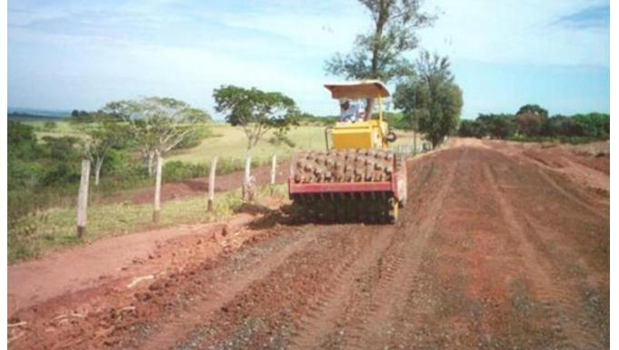
Figura 33 – Processo de compactação do material granular
