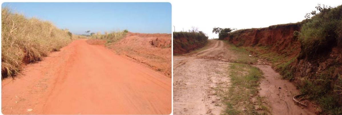
Figura 27 – Estrada rural com necessidade de quebra de barrancos
