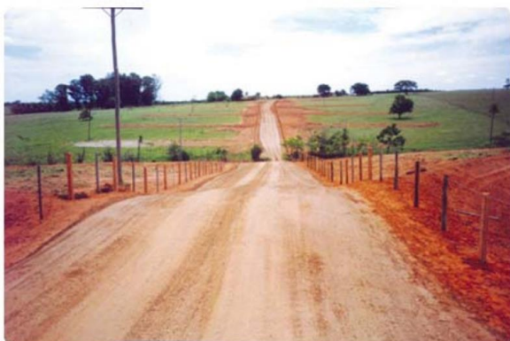
Figura 30 – Lombadas que direcionam as águas pluviais para fora do leito de rolamento
