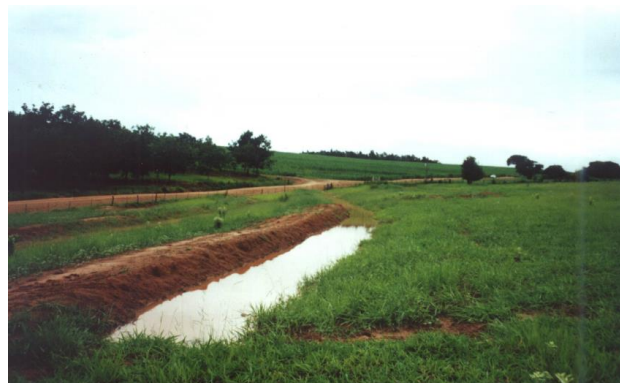
Figura 31 – Terraço em área adjacente a estrada rural
