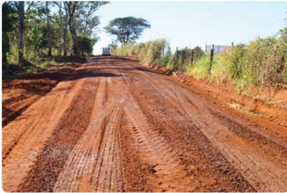
Figura 32 – Aplicação de revestimento primário de material granular
