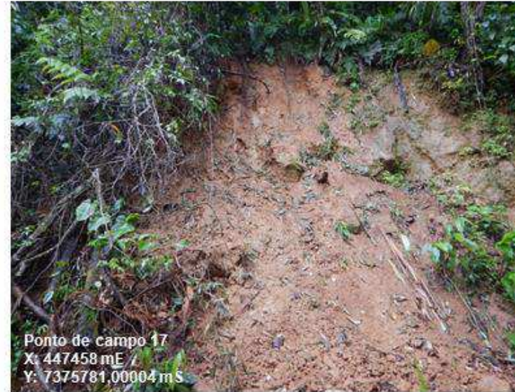
Ponto de escorregamento recente na Unidade V
