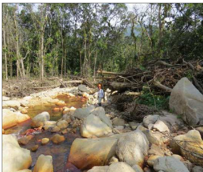
Figura 14. Corrida de detritos em Guaratuba (PR), no ano de 2017, cujo processo danificou a fibra ótica em uma faixa dutoviária da Transpetro (oleoduto OSPAR). Fonte: Arquivo pessoal Claudia Vanessa dos Santos Corrêa.
