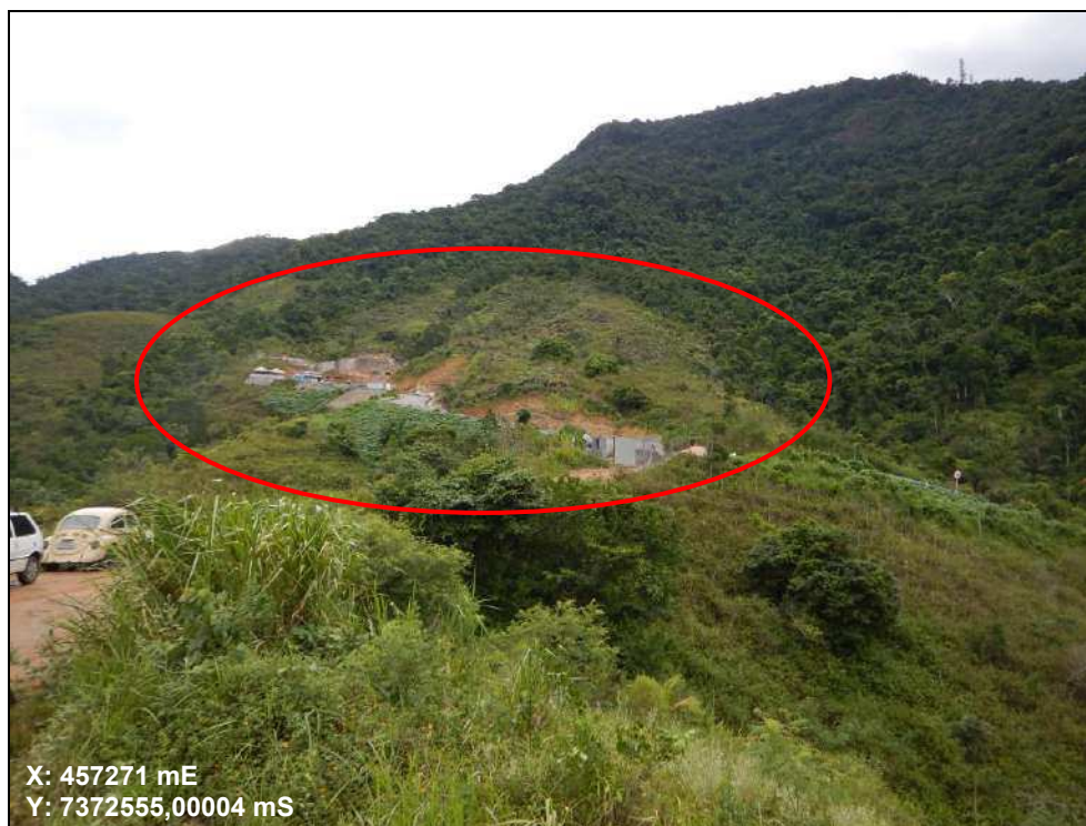
Figura 34. Relevo de escarpas da Serra do Mar com topos angulosos na unidade fisiográfica VIII. Em destaque a construção do túnel do Contorno Sul da Rodovia dos Tamoios (SP- 99). Foto: Arquivo pessoal Fábio Augusto Gomes Vieira Reis.
