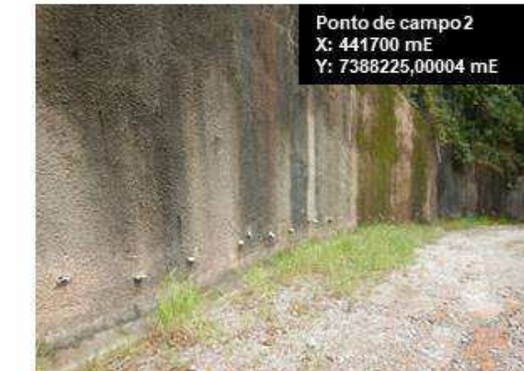
Estrutura de contenção de Talude às margens da Estrada do Duto Gastau com canais para escoamento da água pluvial
