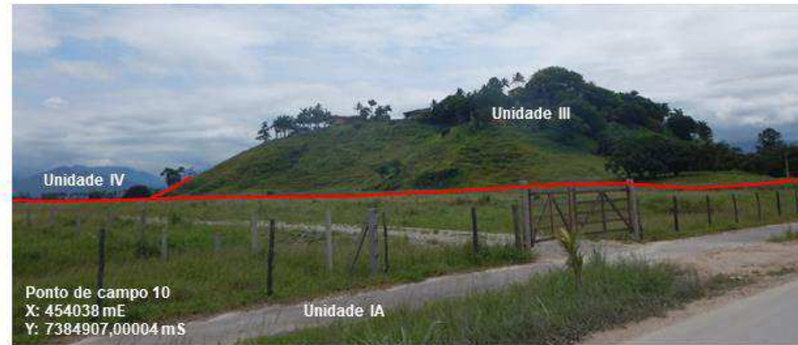
Morro isolado em planície costeira, principal característica da Unidade III
