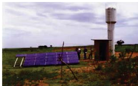
Figura 17: Sistema de bombeamento FV – Santa Cruz I (Mirante do Paranapanema - SP)
