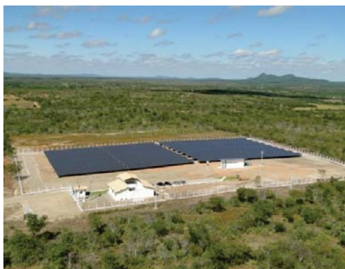
Figura 20: Usina Solar de Tauá
