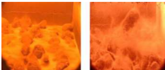
Figura 10 - Leito fluidizado de caldeira em operação.
