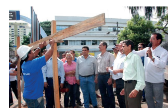
PRAÇA 9 DE JULHO. Foto do início da execução do projeto de reforma da praça, que contou com a presença do Prefeito "Tupã". Fonte: Site da Prefeitura Municipal
