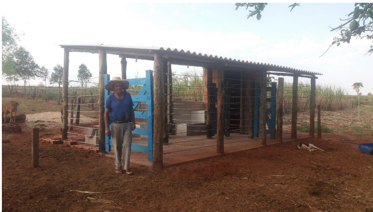
Figura 35 - Exemplo de instalações mais adequadas para ordenha dos animais leiteiros, realizadas com apoio do Programa. Assentamento Alecrim 2018.
