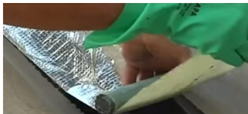
Figura 19 – Aplicação da manta autocolante alumínio.
