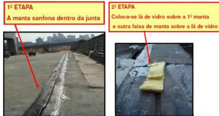
Figura 16 – Detalhe da junta de dilatação.
