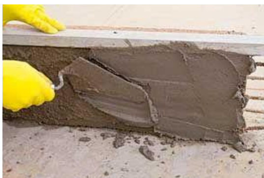
Figura 25 – Aplicação da argamassa impermeável.
