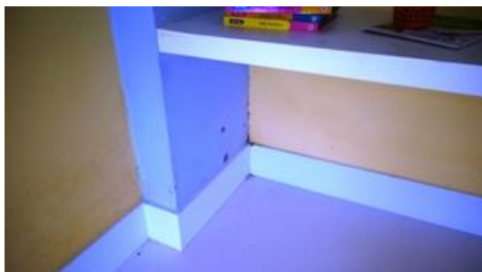
Figura 36 (a) e (b) – Presença de umidade nos rodapés (Brinquedoteca).
