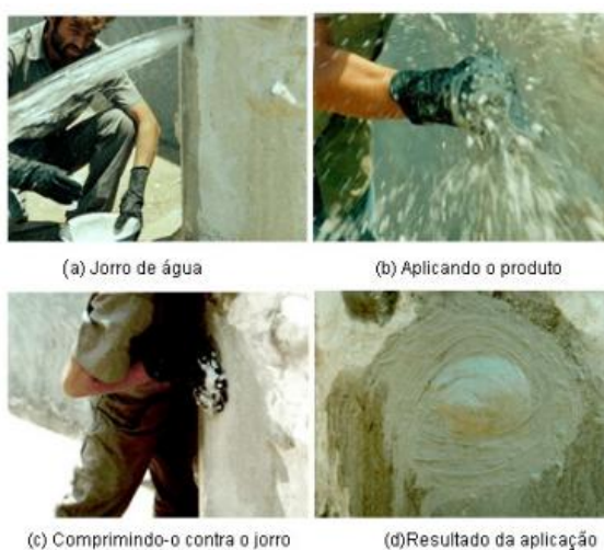
Figura 26 – Aplicação do cimento impermeabilizante de pega ultrarápida.
