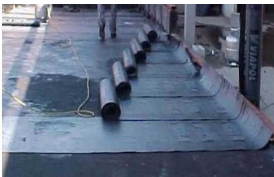
Figura 11– Aplicação da manta asfáltica.
