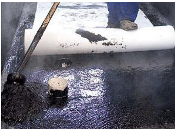
Figura 21 – Aplicação da membrana asfáltica a quente.
