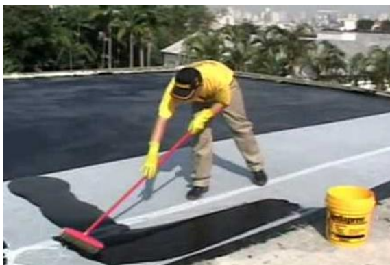
Figura 20 – Aplicação da membrana asfáltica a frio acima do estruturante.
