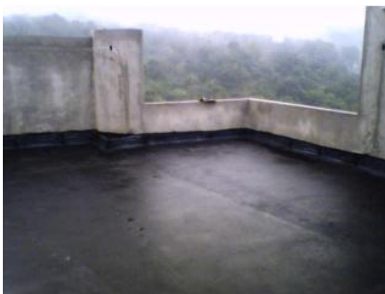
Figura 10 – Imprimação do substrato.
