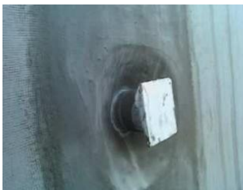
Figura 23 – Utilização da tela de poliéster em tubulação emergente.
