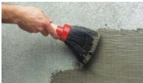
Figura 22 – Aplicação da argamassa polimérica com broxa.
