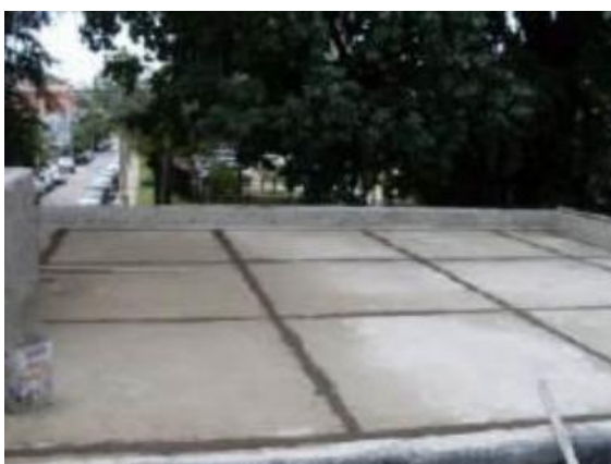
Figura 13 – Proteção mecânica da laje da cobertura.
