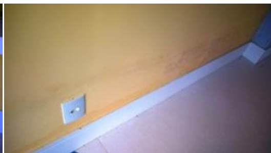
Figura 36 (a) e (b) – Presença de umidade nos rodapés (Brinquedoteca).
