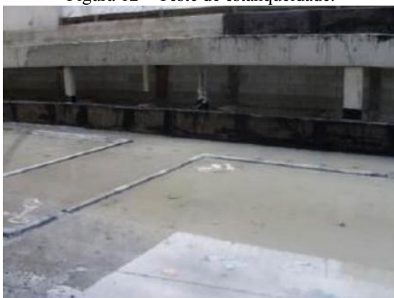
Figura 12 – Teste de estanqueidade.
