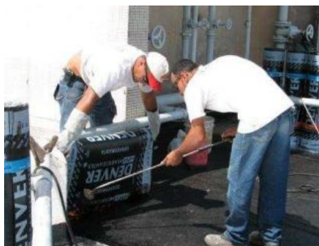
Figura 17 – Aplicação de manta asfáltica com maçarico.
